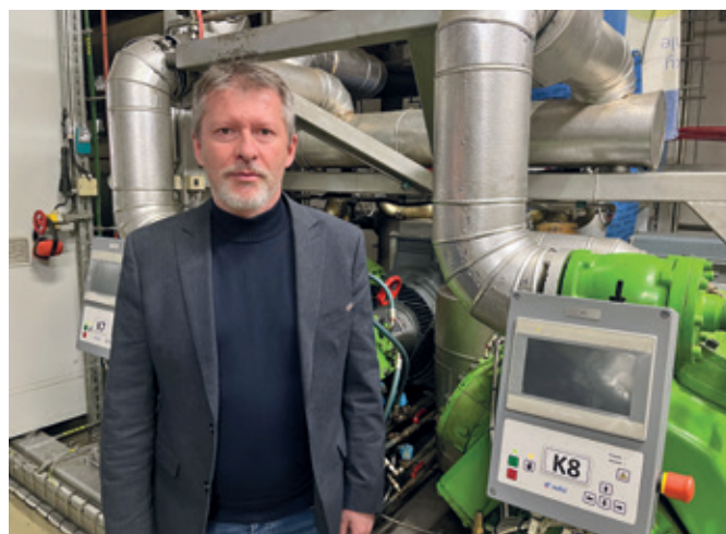
Ing. Jan Sulík u čerpadel geotermálního zdroje
