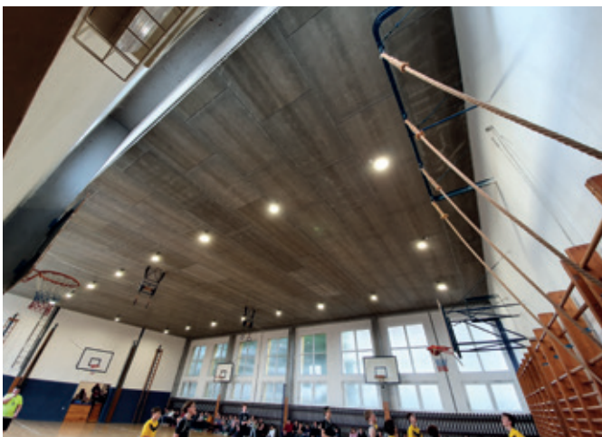
Modernizace osvětlení na úsporné LED zdroje je u zákazníků stále vyhledávanou součástí EPC projektů
