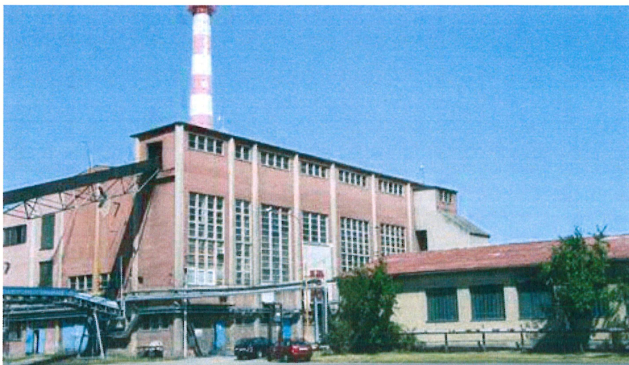
Celkový pohled na uhelnou teplárnu v městské části Mařatice.
