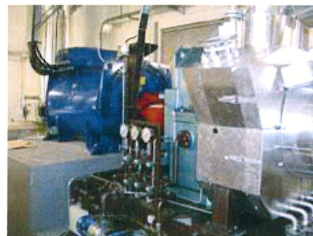
I současná teplárna vyrábí elektřinu. Turbogenerátor o výkonu 1 MW byl v Mařaticích instalován v roce 2009. Foto: CTZ
